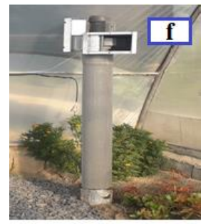
شکل ۱- قراردمی لوله (a)- ایجاد سوراخ جهت خروج اب (b)- شماتیک نحوه ورود هوای خنک به داخل گلخانه و نحوه ورود هوا از داخل و بیرن گلخانه (c) هوای ورودی از داخل- حلقه بسته (d) هوای ورودی از خارج گلخانه-حلقه باز(e)- فن (f)
