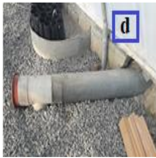
شکل ۱- قراردمی لوله (a)- ایجاد سوراخ جهت خروج اب (b)- شماتیک نحوه ورود هوای خنک به داخل گلخانه و نحوه ورود هوا از داخل و بیرن گلخانه (c) هوای ورودی از داخل- حلقه بسته (d) هوای ورودی از خارج گلخانه-حلقه باز(e)- فن (f)
